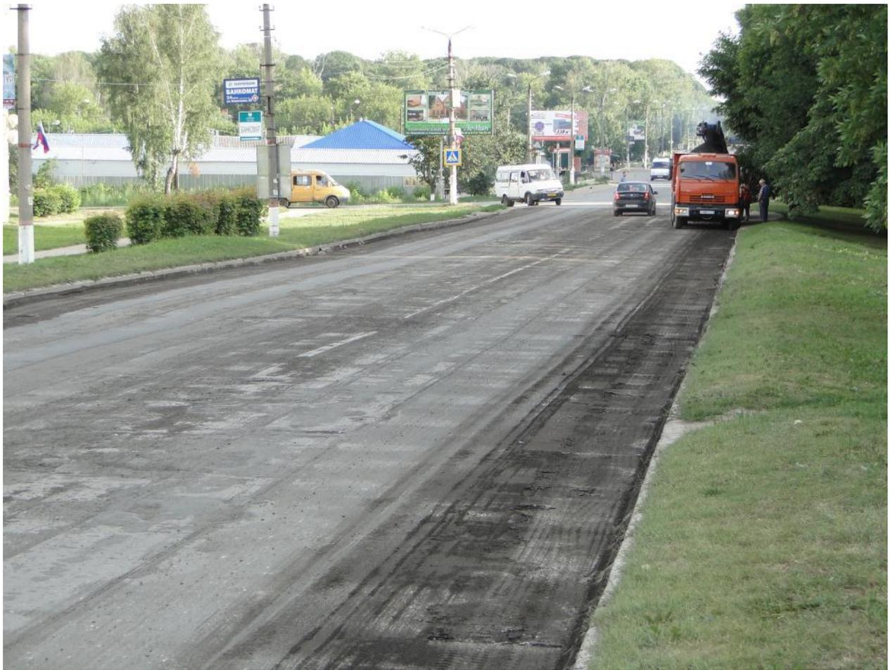
Подготовка поверхности (фрезерование асфальта)
